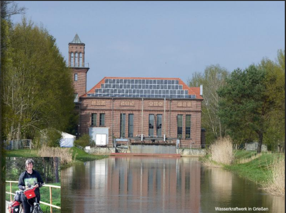
Wasserkraftwerk in Grieben
